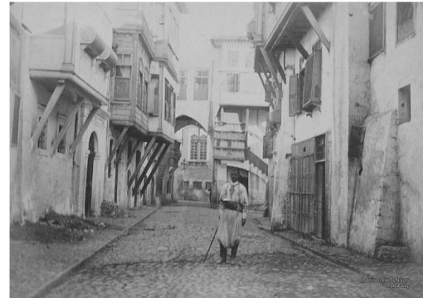
σαχνισί ή καφασωτό σπίτι, ξύλινος εξώστης
