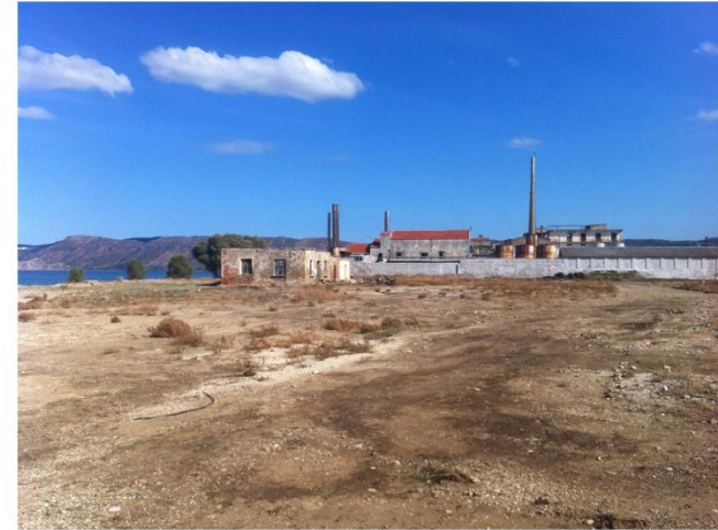
άποψη εγκαταλελειμμένης βιομηχανικής μονάδας
