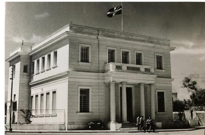
Κτίριο Τράπεζας της Ελλάδος 1952
