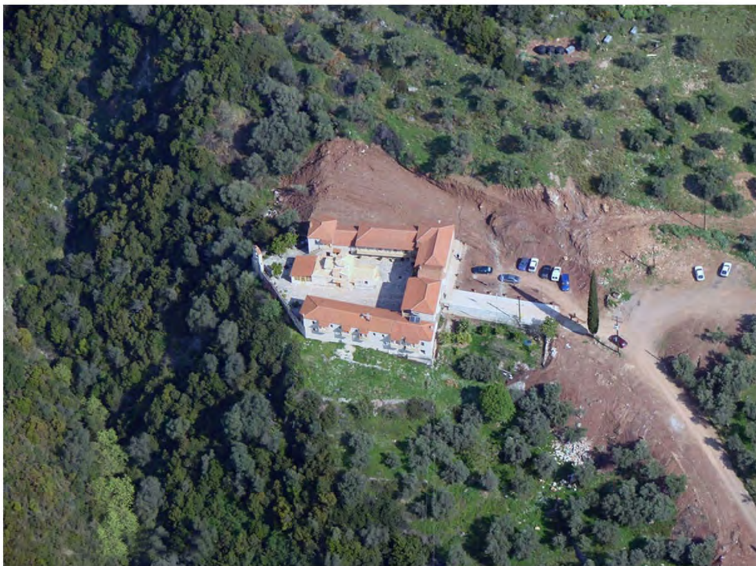
πανοραμική άποψη του μοναστηριακού συγκροτήματος μετά την εκσκαφή
