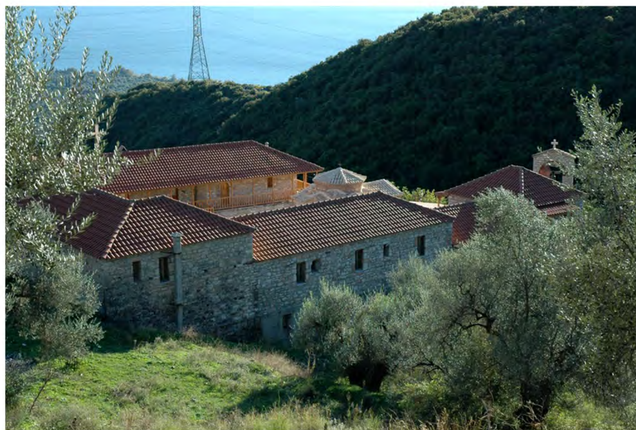
Απόψεις της βόρειας πτέρυγας πριν την εκσκαφή
