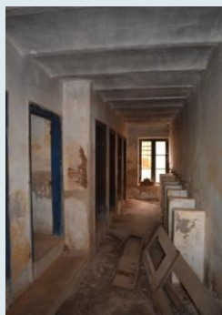
Χώροι υγιεινής στο ισόγειο
