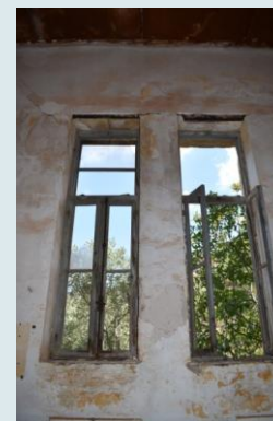
Ποδιά σε παράθυρο στον όροφο. Διακρίνεται η τσιμεντοκονία στην εξωτερική πλευρά
