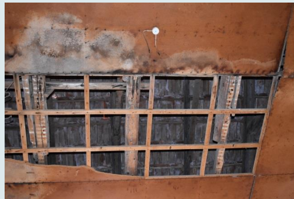
Κατάρρευση ταβανώματος λόγω κενού στη στέγη στο δωμάτιο του επιτηρητή
