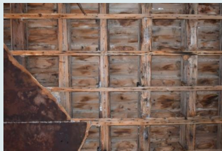
Αποψη ξύλινου δαπέδου ορόφου από το ισόγειο
