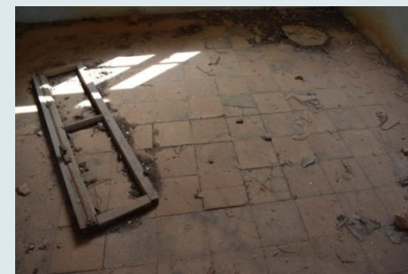
Δάπεδο με θολίσκους από οπτόπλινθους και σιδηροδοκούς και επικάλυψη με πλακάκια
