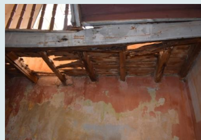
Αποψη του πλατύσκαλου με εμφανή την υποχώρηση που παρουσιάζει
