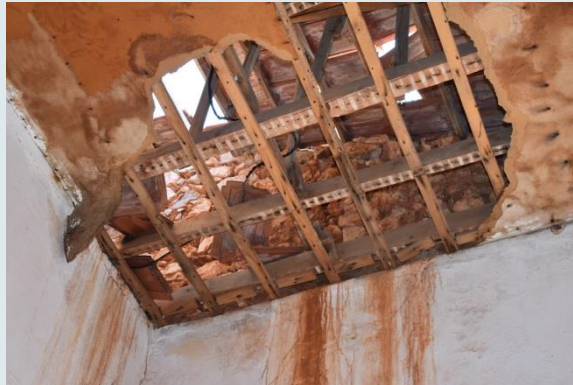
Κατάρρευση ταβανώματος λόγω κενού στη στέγη στο δωμάτιο του επιτηρητή
