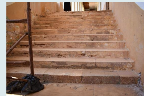
Μηχανική καταπόνηση και παραμόρφωση των λίθινων πατημάτων
