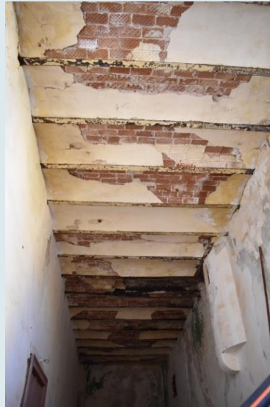
Οροφή στοάς με θολίσκους από οπτόπλινθους
