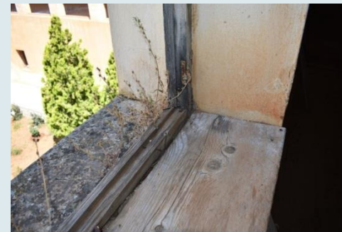
Ποδιά σε παράθυρο στον όροφο. Διακρίνεται η τσιμεντοκονία στην εξωτερική πλευρά
