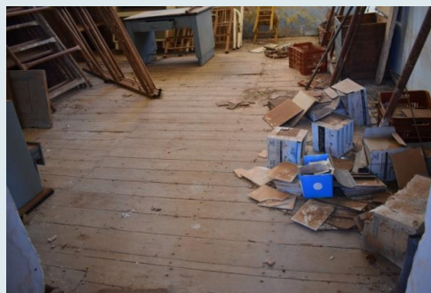
Ξύλινο δάπεδο ισογείου
