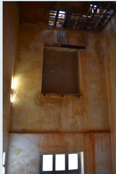
Υγρασία στην τοιχοποιία από τα όμβρια ύδατα
