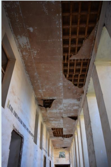
Ξύλινη οροφή στοάς με επένδυση από φύλλα hardboard
