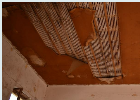
Οροφή νότιου τμήματος ορόφου με πηχάκια και επένδυση από φύλλα hardboard
