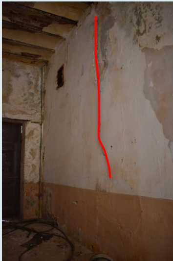
Δυτική τοιχοποιία σε επαφή με το κοιμητηριακό συγκρότημα
