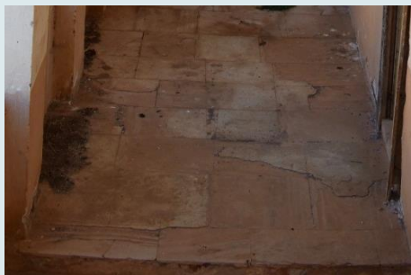
Λίθινες πλάκες στη στοά του ισογείου
