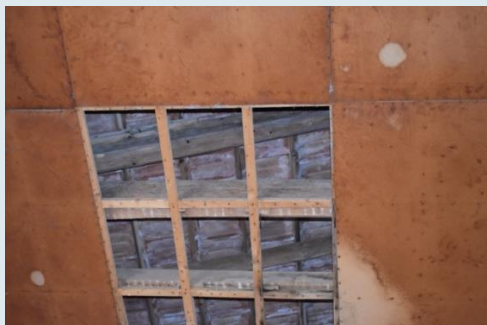
Οροφή βόρειου τμήματος ορόφου με επένδυση από φύλλα hardboard
