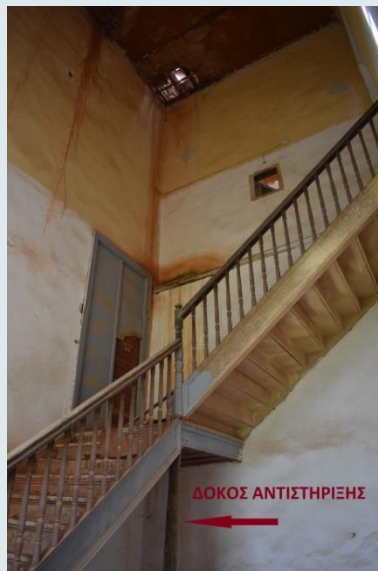
Προσωρινή αντιστήριξη του άνω πλατύσκαλου με ξύλινη δοκό.
