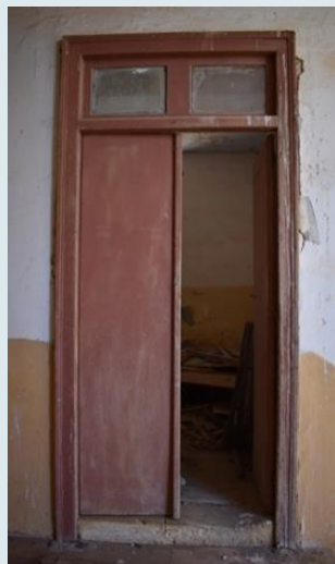
Εξωτερική όψη θυρώματος ισογείου
