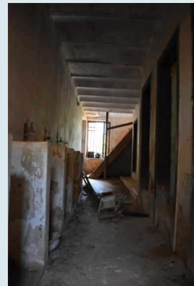
Δάπεδο χώρων υγιεινής από τσιμεντοκονία
