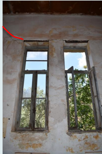
Ρωγμές στα υπέρθυρα και στις ποδιές των ανοιγμάτων
