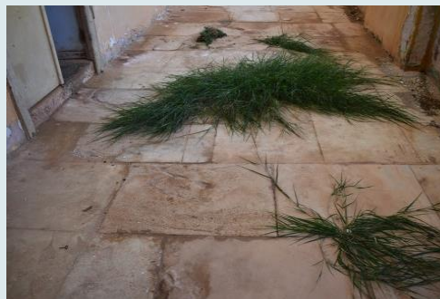
Βλάστηση και κυψέλωση λίθων
