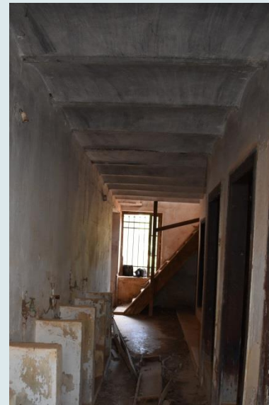
Οροφή χώρων υγιεινής με θολίσκους από οπτόπλινθους
