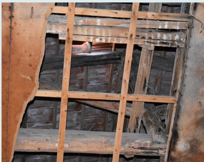
Μερική άποψη του ζευκτού της βόρειας στέγης
