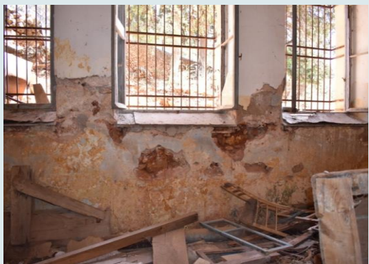
Αποσάθρωση και αποκόλληση κονιάματος σε αίθουσα του ισογείου
