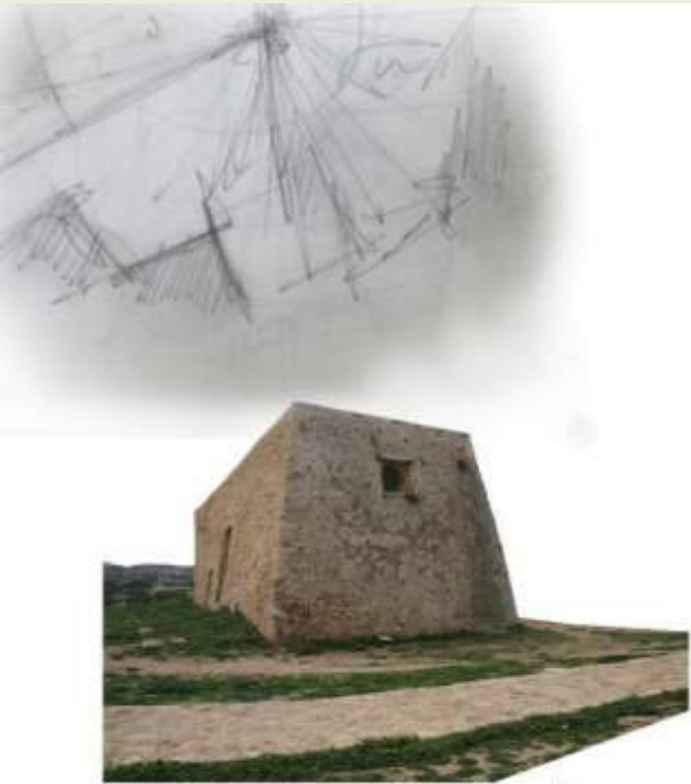
Τμήμα κατοικίας Ρέκτορα (φυλακές)
