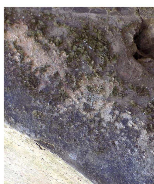
/6/ Ανατολ. (στεγασμένη) πλευρά- Λειχήνες και βρύα
