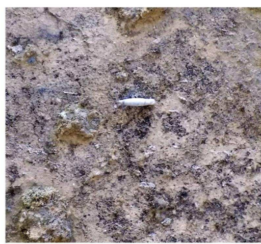
/8/ Ανατολ. (στεγασμένη) πλευρά - Οστρακοειδείς οργανισμοί και απολέπιση ζωγραφικής επιφάνειας
