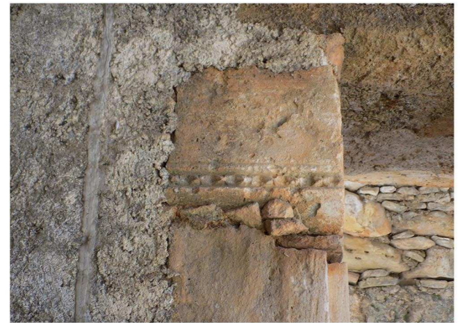
/4/ Μαύρες βιολογικές επικαθίσεις στους ανεπίχριστους λίθους στα πλαίσια των ανοιγμάτων
