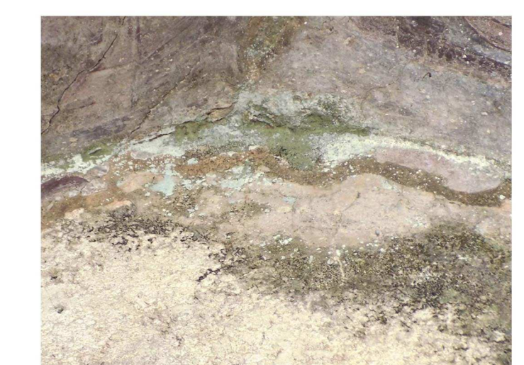
/4/ Άλγη, μαύρες βιολογικές κρούστες και άλατα
