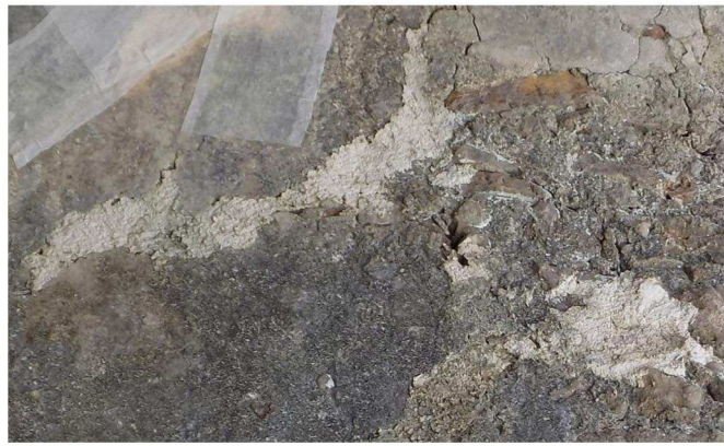
/1/ Επίχρισμα τσιμεντοκονιάματος και μαύρη κρούστα οφειλόμενη πιθανώς στη δράση βιολογικών παραγόντων
