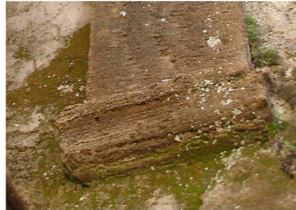
/3/ Διαφορική διάβρωση και απολέπιση εμφανών λίθων. Ανάπτυξη άλγερων επάνω στο κονίαμα. Λευκά σημάδια από λειχήνες
