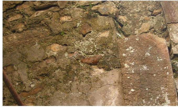
/2/ Ανάπτυξη άλγερων επάνω στους λίθους και το κονίαμα. Φυτά στις ρωγμές της τοιχοποιίας. Λευκά σημάδια από λειχήνες
