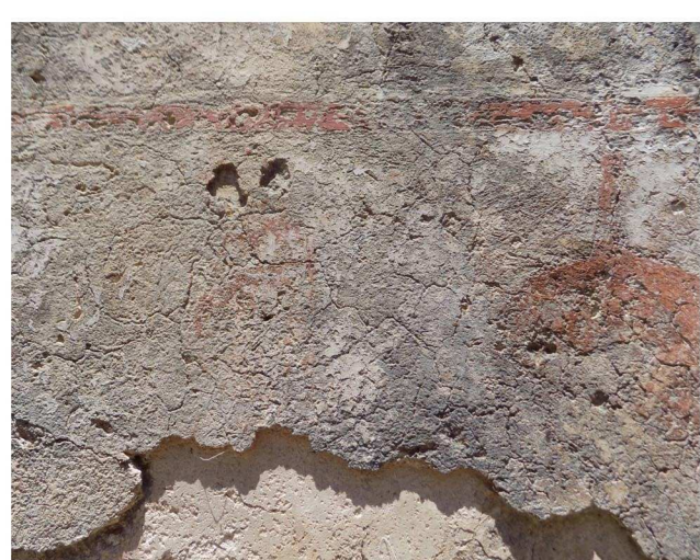
/2/ Δυτική (ασκεπής) πλευρά - Χρωματική αλλοίωση (ιδιαίτερα ξεθωριασμένα χρώματα), δίκτυο τριχοειδών ρωγμών (microcracks), απολέπιση και κρυστοποίηση της ζωγραφικής επιφάνειας, γκρι βιολογικό φίλτρο
