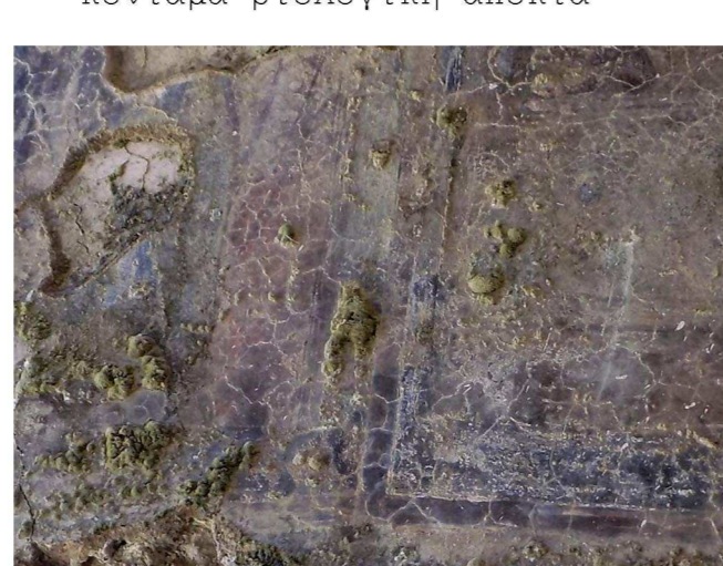
/5/ Ανατολ. (στεγασμένη) πλευρά - Απολέπιση της ζωγραφικής επιφάνειας και χρωματική αλλοίωση, αλλά μικρότερης έντασης από το δυτικό τμήμα της όψης, κροακάλισμα, λευκό βιολογικό φίλμ, βρύα
