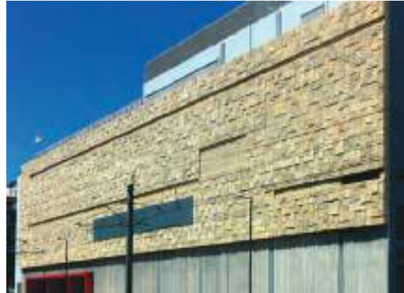
Εικ. 21: Αποκατάσταση & επανάχρηση εργοστασίου «Φίξ» σε Ε.Μ.Σ.Τ., αρχιτέκτονες Ι. Μουζάκης, 3SK Στυλιανίδης & συνεργάτες, 2016.
