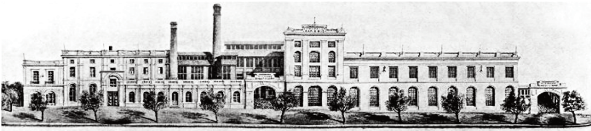
Εικ. 19: Εργοστάσιο «Φίξ» στη λεωφόρο Συγγρού, 1893.
