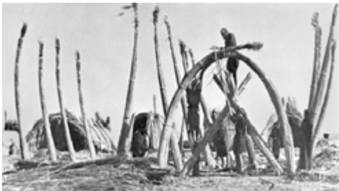
Εικ. 3.8: Κατασκευή σπιτιών αξιοποιώντας τις ελαστικές ιδιότητες του ξύλου. Madan people, Mudhif houses, Southern Iraq
