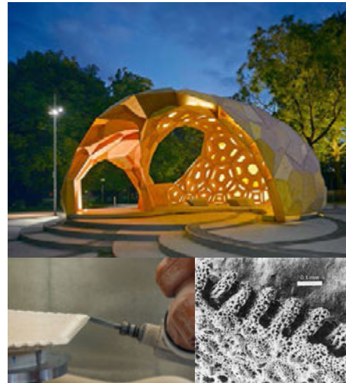
Εικ. 3.4: ICD/ITKE Research Pavilion 2011. Ελαφριά κατασκευή από ξύλο που μιμείται την κυτταρική δομή των εχινοειδών.
