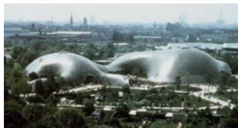
Εικ. 4.16: Αεροφωτογραφία του ολοκληρωμένου Multihalle.
