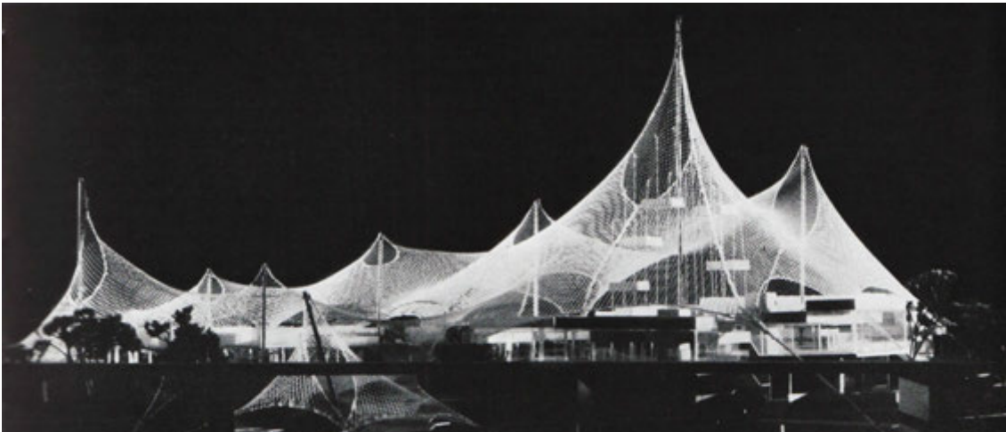
Εικ. 1.5: Διερευνητικό μοντέλο από τούλι που απεικονίζει το Γερμανικό περίπτερο για την Παγκόσμια Έκθεση του Μόντρεαλ 1967
