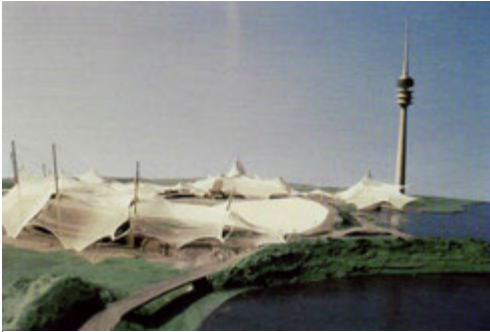
Εικ. 1.29: Διερευνητικό μοντέλο από τούλι του στέγαστρου
