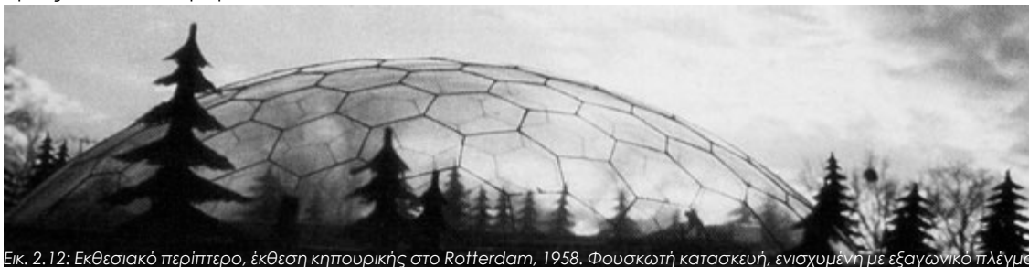
Εικ. 2.12: Εκθεσιακό περίπτερο, έκθεση κηπουρικής στο Rotterdam, 1958. Φουσκωτή κατασκευή, ενισχυμένη με εξαγωνικό πλέγμα.
