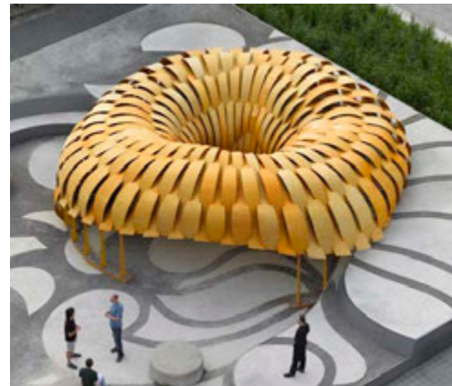
Εικ. 3.5: ICD/ITKE Research Pavilion 2010. Ελαφριά κατασκευή από ξύλο που βασίζεται στις ελαστικές ιδιότητες του ξύλου.
