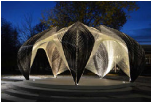
Εικ. 3.2: ICD/ITKE Research Pavilion 2013-14. Ελαφριά κατασκευή από fiberglass και ανθρακόνημα. Αποτελείται από αλληλένδετες κυψέλες που κατασκευάζονται από δυο ρομποτικούς βραχίονες. Η κατασκευή μιμείται την κυτταρική δομή του έλυτρου.
