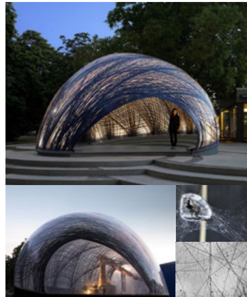
Εικ. 3.1: ICD/ITKE Research Pavilion 2014-15 Ελαφριά κατασκευή από fiberglass και ανθρακόνημα που κατασκευάζεται αποκλειστικά από τομποτικό βραχίονα.. Μέθοδος κατασκευής που μιμείται τον τρόπο με τον οποίο κατασκευάζει η αράχνη του νερού (Agryponeda Aquatica) τη φωλιά της.
