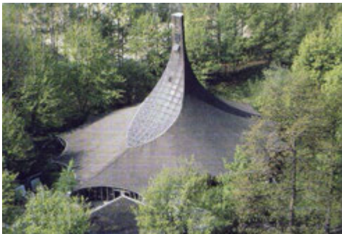
Εικ. 1.7: Η οροφή του Institute for Lightweight Structures (IL), στη πανεπιστημιούπολη της Στουτγάρδης στο Vaihingen.
