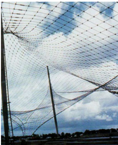
Εικ. 1.22: Το μεταλλικό πλέγμα του περιπτέρου μετά την τοποθέτησή του
