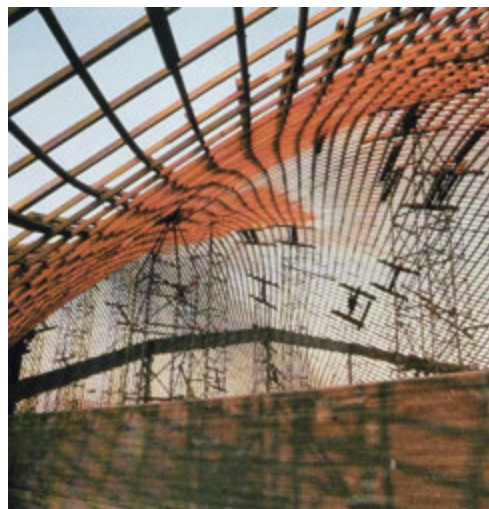
Εικ. 4.17: Φωτογραφία από το εσωτερικό του κελύφους που φαίνονται οι σκαλωσιές που χρησιμοποιήθηκαν για την ανέγερση του.
