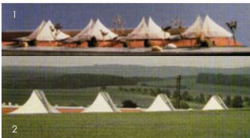
Εικ. 3.5: 1) Μοντέλο κρεμαστών αλυσίδων της επέκτασης του εργοστασίου. 2) Φωτογραφία των υλοποιημένων κτιρίων.
