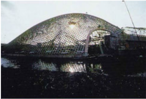
Εικ. 4.18: Φωτογραφία κατά τη διάρκεια της κατασκευής του Multifihalle.
