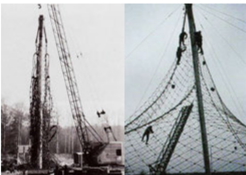
Εικ. 1.24: Φωτογραφίες από το στήσιμο της οροφής
