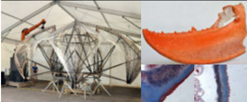
Εικ. 3.3: ICD/ITKE Research Pavilion 2012. Ελαφριά κατασκευή από fiberglass και ανθρακόνημα που μιμείται τη μοριακή δομή του εξώσκελετού των μαλακόστρακων. Υλοποιείται αποκλειστικά από ρομποτικό βραχίονα.
