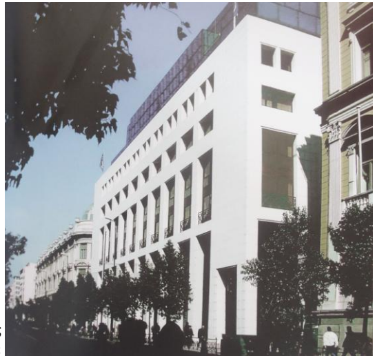
6_ το κτίριο Διοίκησης της Τραπέζης Πίστωσης που τα αντικατέστησε
