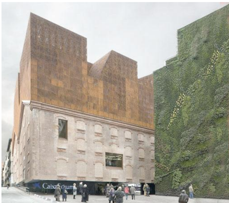
8 _ Caixa Forum _ Madrid _ Herzog & de Meuron _ 2008 _ ισχυρή επέμβαση, όπου διατηρήθηκαν οι όψεις του προϋπάρχοντος κτίσματος, προστέθηκε με σύγχρονα υλικά ένας νέος όγκος, ενώ το κτίσμα αποκολλήθηκε από το έδαφος για τη δημιουργία στεγασμένης πλατείας
