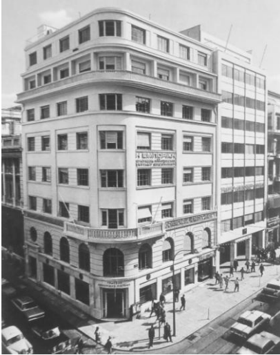
5_ κτίρια επί της Σταδίου που κατεδαφίστηκαν
