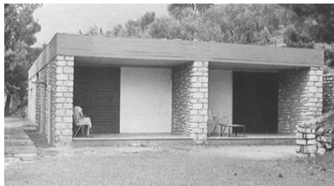
103. Ημιυπαίθριος χώρος ξενώνα
