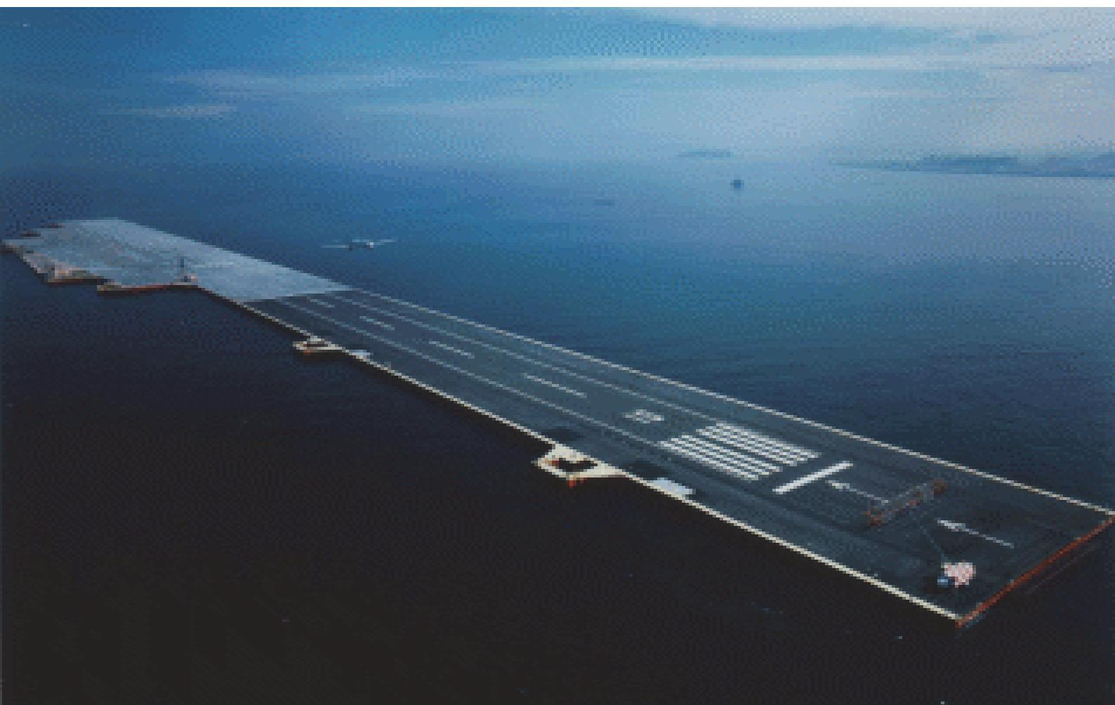
**Εικόνα 4:** Mega float αεροδιάδρομος Τόκιο
