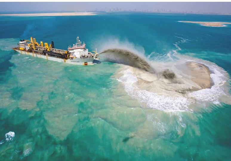
**Εικόνα 5:** Κατασκευή του τεχνητού νησιού
