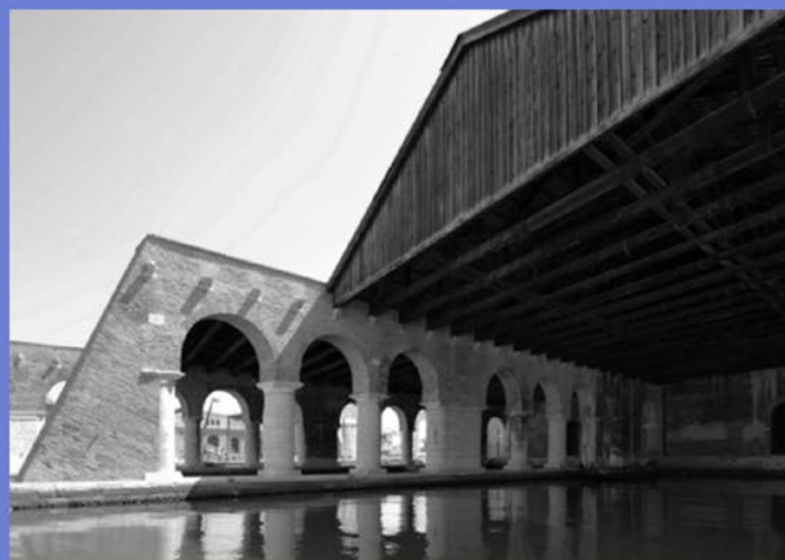
Νεώριο Βενετίας. Η μεταλλική υποστηρικτική κατασκευή για το έργο της επέμβασης στα ζευκτά των στεγών στις θέσεις Gaggiandre
