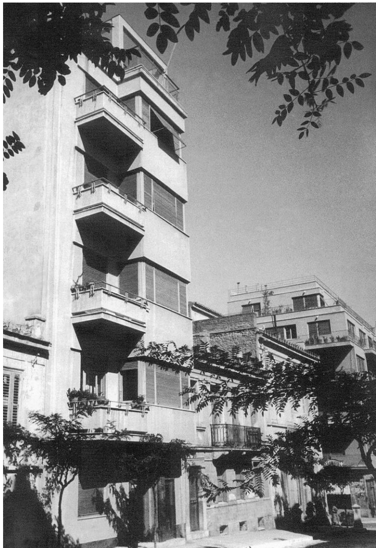
Πολυκατοικία οδού Διδότου 47 (1935), Αθήνα. Αρχιτέκτων Ορέστης Μάλτος ©Αρχείο Ελένης Φεσσά-Εμμανουήλ
