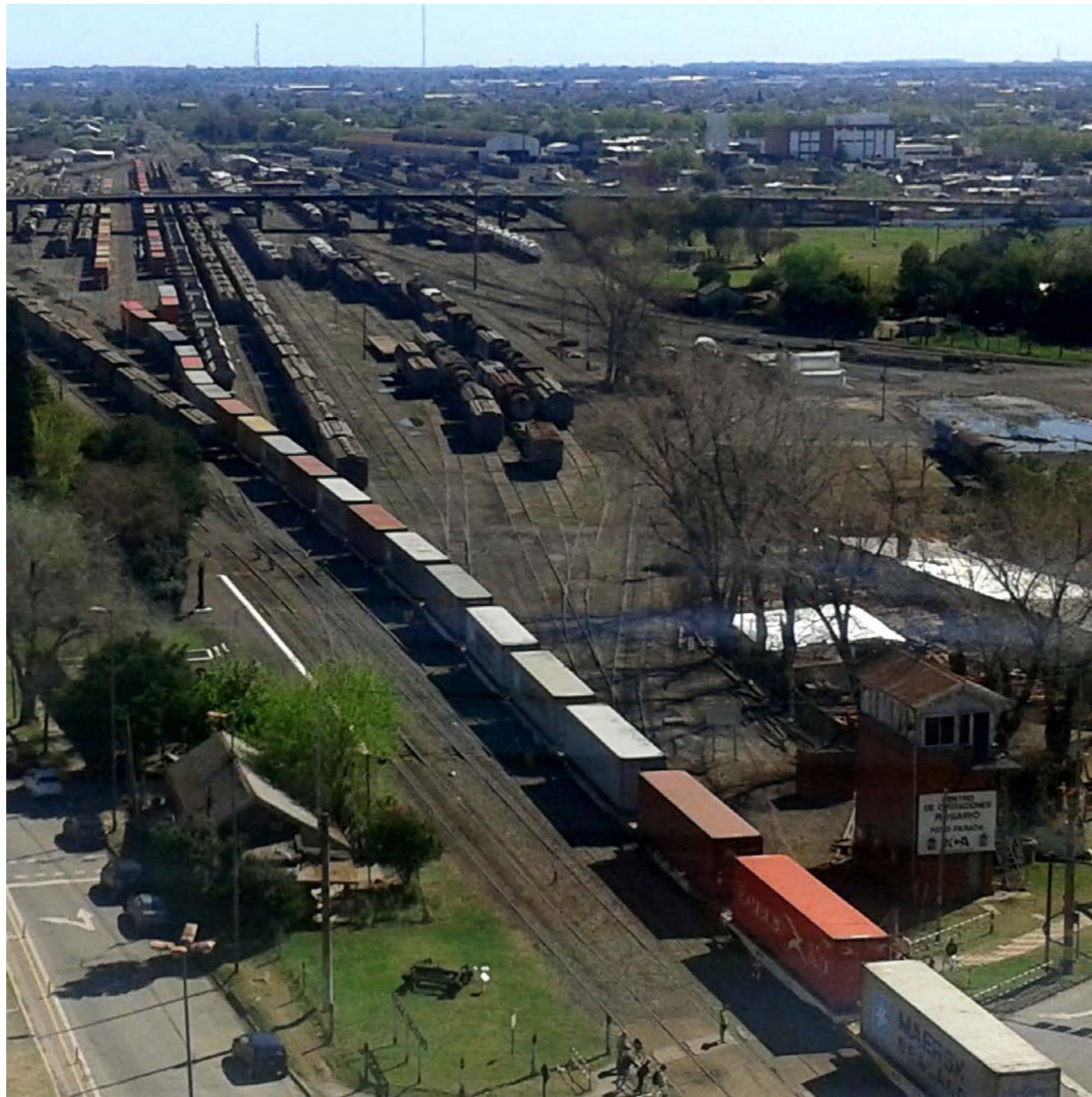
[4] CRUCE ALBERDI | Nueva Estación Intermodal [4] CRUCE ALBERDI | New Intermodal Station
